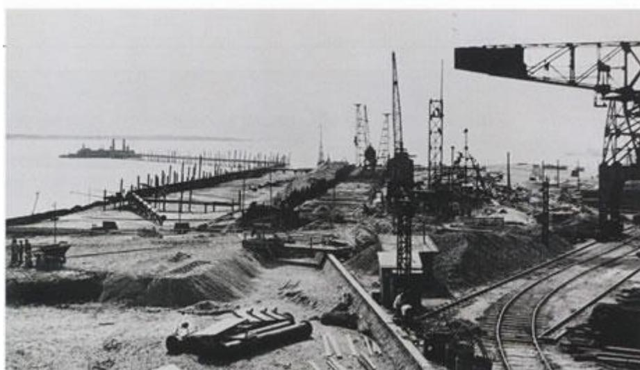
Dès 1929, bien avant d'être finalisé, le projet "Normandie" a nécessité la réalisation d'importants travaux à Saint-Nazaire, tels ceux d'une nouvelle cale de construction, seule en mesure d'accueillir un aussi vaste chantier.
