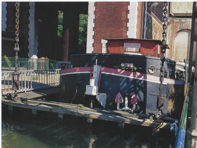
L'ascenseur des Fontinettes dans son état actuel : en haut à gauche, la roue crantée actionnant les deux couples de compresseurs ; à droite, le petit compresseur à air qui servait à gonfler la poche en caoutchouc assurant l'étanchéité entre le sas et le pont-canal ; ci-dessus, un bateau montant engagé dans le sas, porte fermée.
